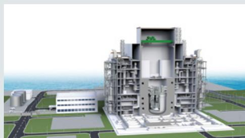
ナトリウム冷却タンク型高速炉
