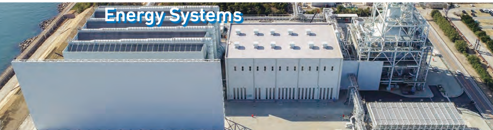
高砂工場 実証設備複合サイクル発電所 第2号発電設備
