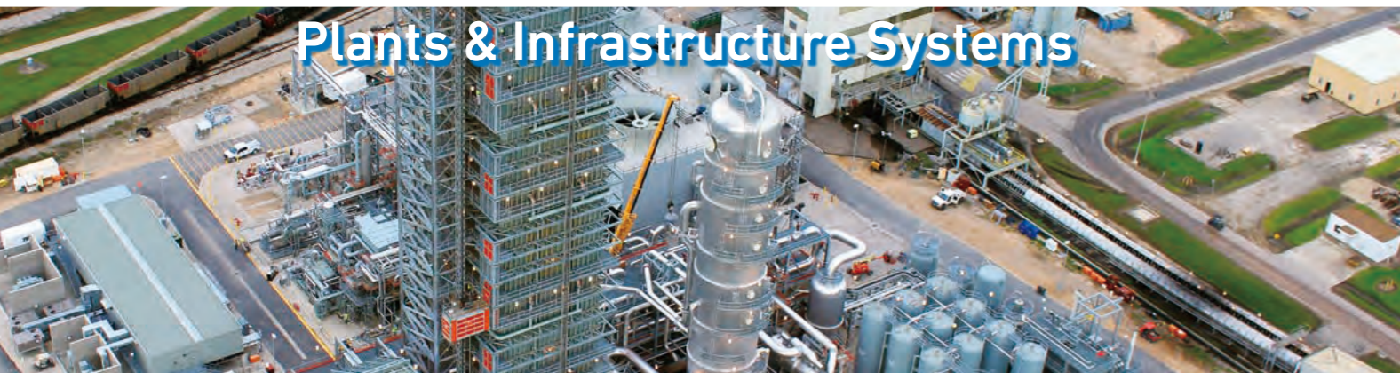
石炭燃焼排ガスを対象とした世界最大のCO 2 回収プロジェクト(米国テキサス州ヒューストン)
