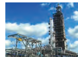
CO 2 回収プラント
