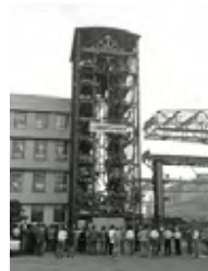
立体駐車場1号機(1963年)
