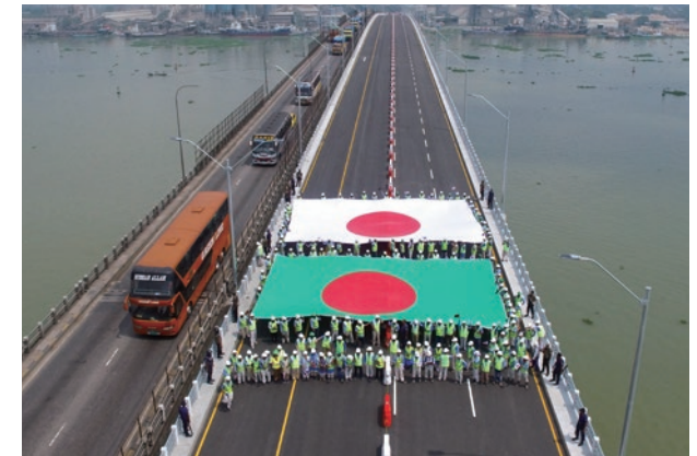
メグナ新橋完成時（左側が既存橋、右側が新橋）
