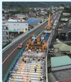
橋梁の床版取替工事
