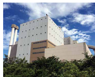
2004(H16)年にIHIが納めた (株)神戸製鋼所 神戸発電所2号機
