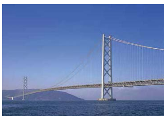
明石海峡大橋
