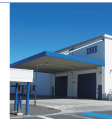
鶴ヶ島工場の外観写真
