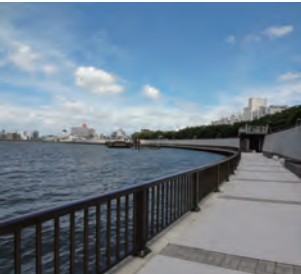
気候変動への適応(高潮防御施設の整備)
