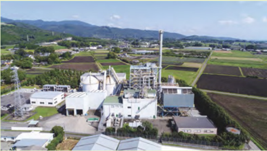
バイオマス発電第1号機
