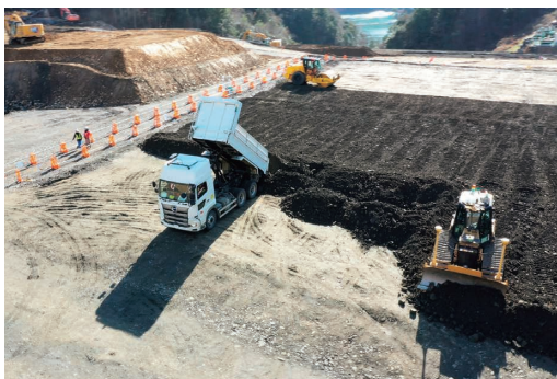
自動運転ダンプトラックのDX施工の実証実験 ＜荷下ろしエリア＞
