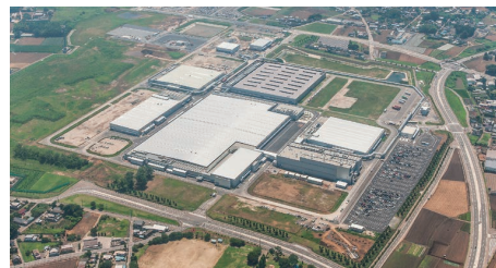
古河工場全景
