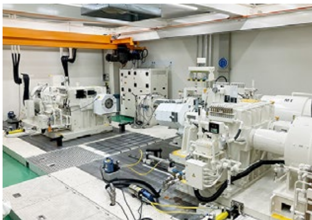
先進の試験設備(3軸ダイナモメーター)
