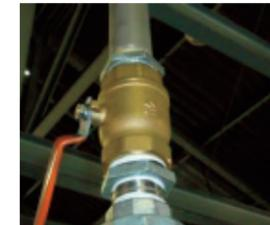
冷却水の配管径を太くするとともに、配管材質をスケールが附着しにくいステンレスにしました。
