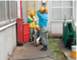
野外消火栓も使用
