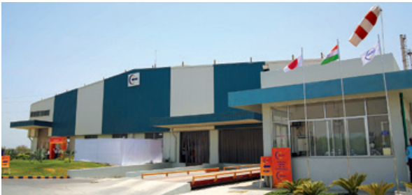
新設したパノッド工場
