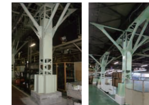
藤沢工場 耐震補強工事
