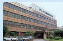
本社・川崎工場
