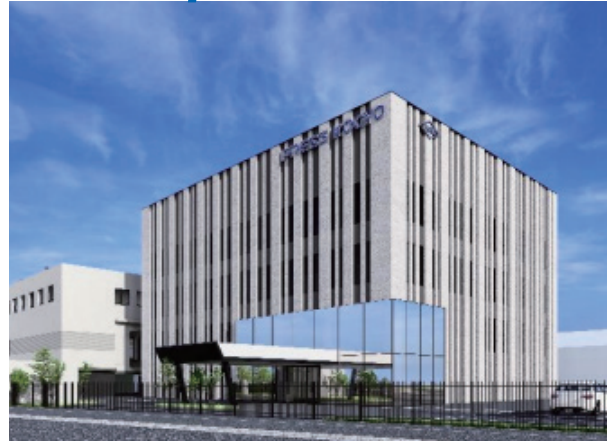
※本社建替え。2026年10月竣工予定
