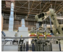
フレーム用ショットプラスト設備
