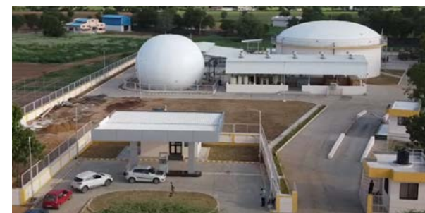
Banas Dairy社バイオガス精製プラント
