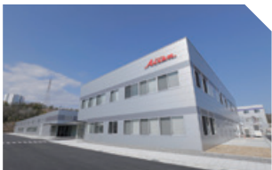
広瀬テクニカルセンター
