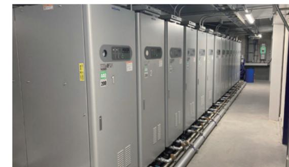
塗装ボイラーを電気式に変更した設備
