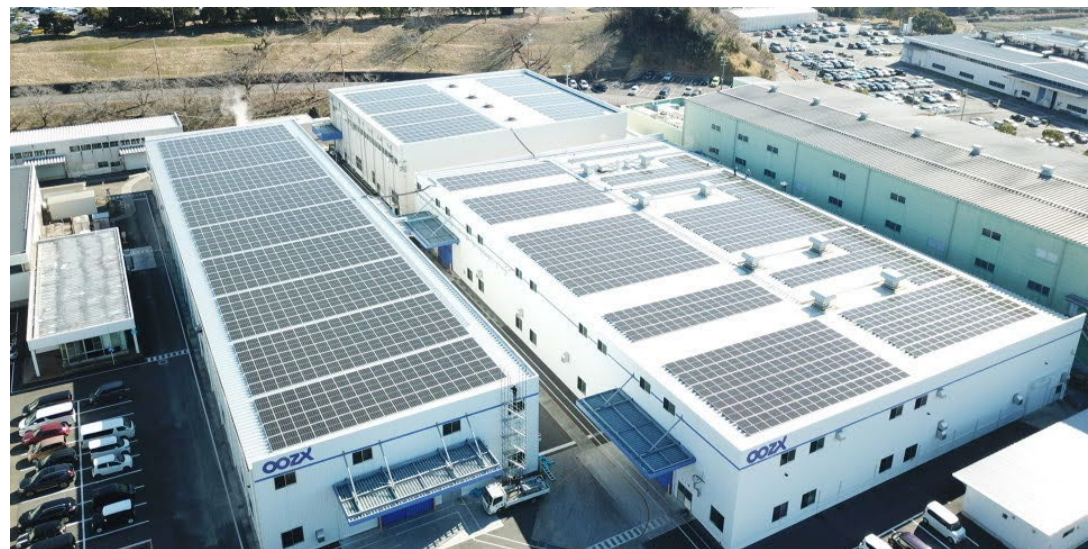
静岡工場の太陽光発電パネル
