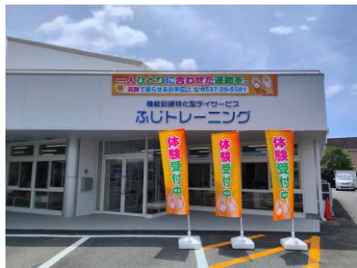
ふじトレーニングの建屋外観
