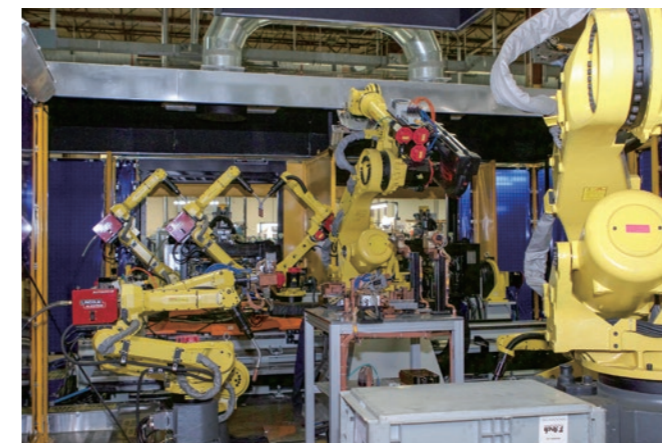
2015年導入の最新溶接設備
