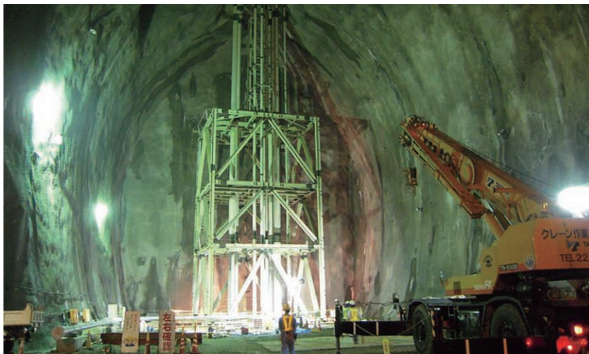
波方国家石油ガス備蓄基地 建設当時の地下岩盤貯槽 (写真提供: 独立行政法人石油天然ガス・金属鉱物資源機構)
