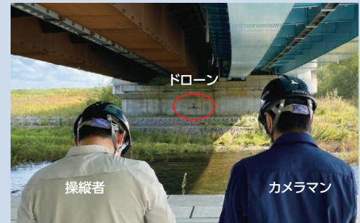
無人航空機を用いた橋梁の損傷の把握状況
