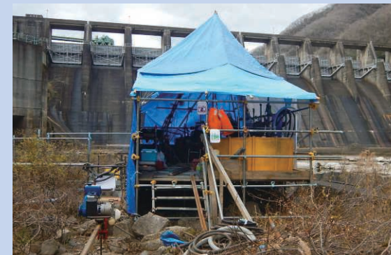
ダム再生事業におけるボーリング調査
