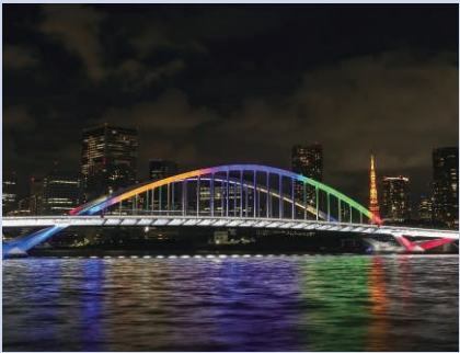
築地大橋 (東京都中央区)
