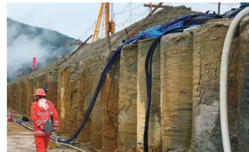
盛土の安定化対策(深層混合処理工法)の例
