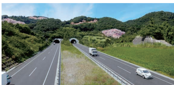
高田山トンネル終点側坑口のイメージ図_左側が現道供用中で、右側が計画(CG)の2期線
