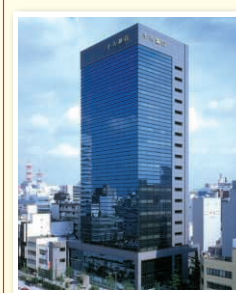
名古屋ビル(名古屋市)
