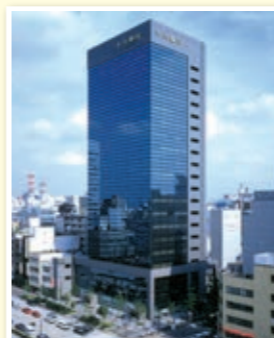
名古屋ビル(名古屋市)
