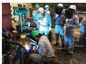
鉄骨資材研修での溶接実習
