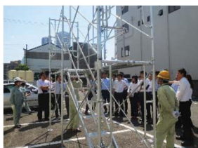
仮設資材研修での組み方実演
