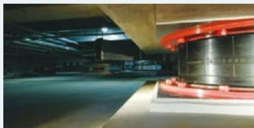
震災時に商品が落下損壊したり、物流設備が故障することを避けるため、物流センターをはじめ、全建屋の耐震・免震化を進めています。
