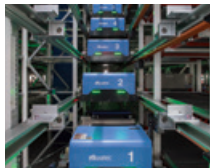
ユニシャトル (入出庫能力を持つ) 自動倉庫システム
