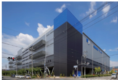
ハピネット東大阪ロジスティクスセンター（大阪府東大阪市）
