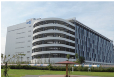
ハピネット船橋ロジスティクスセンター（千葉県船橋市）
