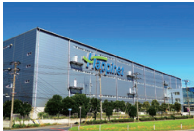
ハピネット市川ロジスティクスセンター（千葉県市川市）
