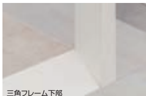
三角フレーム下部
