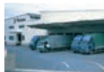
中央ロジスティックセンター
