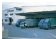
中央ロジスティックセンター
