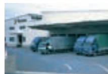
中央ロジスティックセンター
