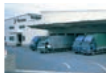
中央ロジスティックセンター
