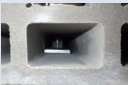
ECPへの「CSプレート」取付け状況
