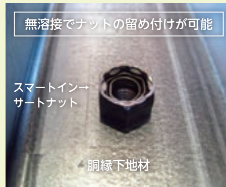
銅縁下地材への取付けの様子
