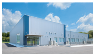
竣工した宇宙棟
