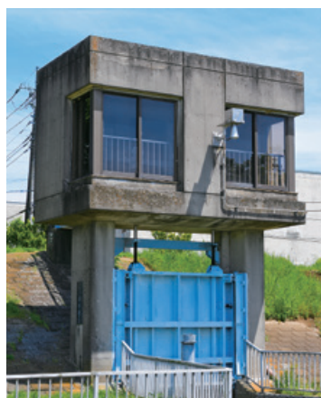
流向計の設置された水路
