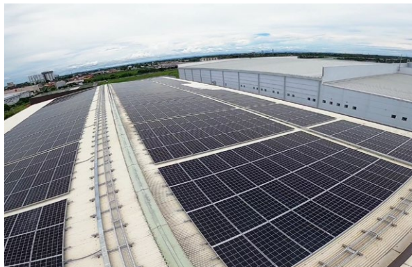
太陽光パネルの設置
