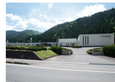
メニコンネクト 郡上工場
