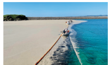
OKシルトフェンス/オイルフェンス
