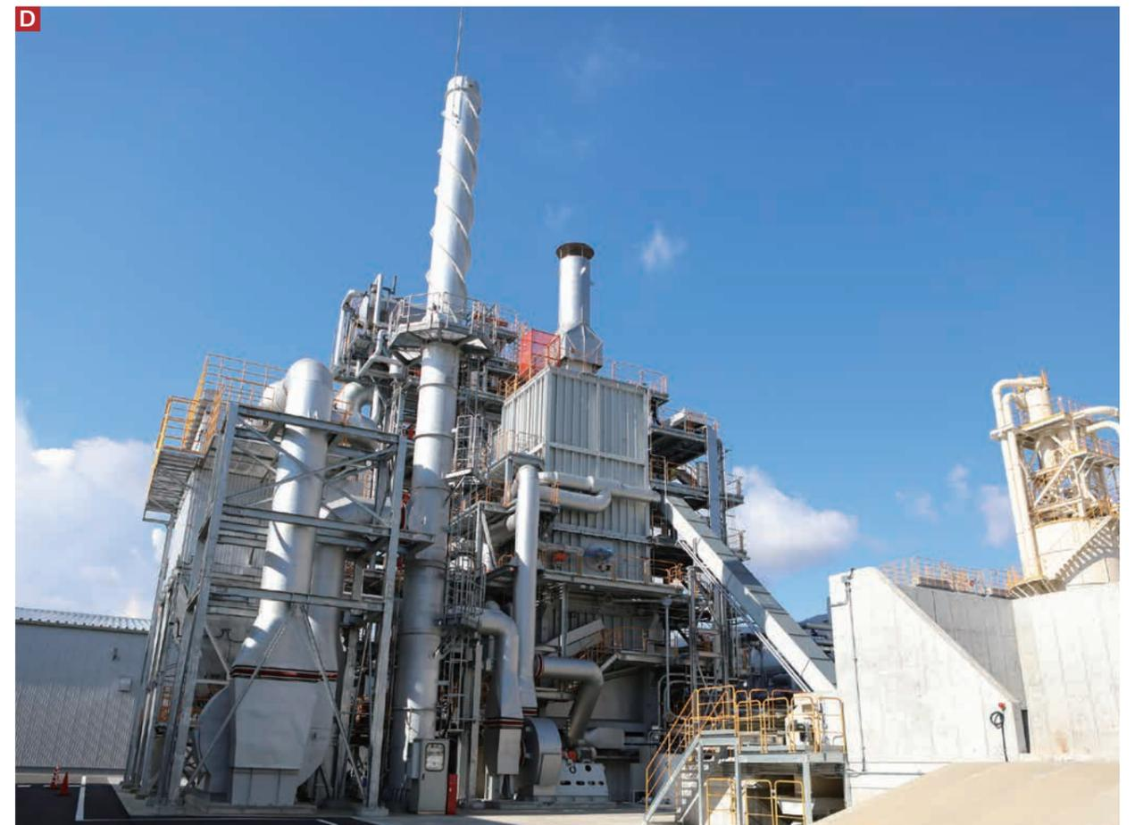
画像Dの巨大な設備は、環境に配慮した化石燃料(重油)を用いないバイオマスボイラーです。蒸気を作ると同時に油も熱しています。蒸気は木材チップを乾燥させるドライヤーに、また油はPBを圧縮する連続プレスの熱源に利用されます。建物(画像C)でふるい分けられた結果、PBに不向きな木材チップは別のダクトから排出され、燃料用としてこのボイラーに投入されます(サーマルリサイクル →13・15ページ)。
