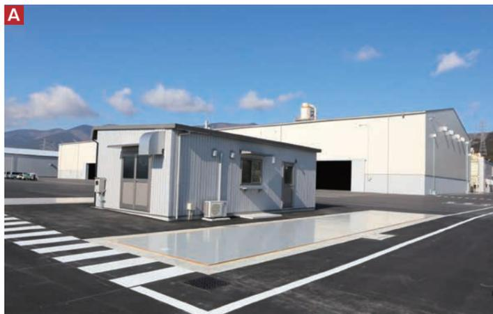
上空から見える画像Aは木材チップの計量棟です。地面の白い鉄板の上に木材チップを積載したトレーラーが乗ると、トレーラーの重量を差し引いて、自動的に木材チップの重量が計算されます。この計量用の鉄板は15mに設定されていますので、トレーラーヘッド(運転席のある部分)と荷台を切り離す必要がなく、運送業者の待機時間短縮に役立ちます。また、計量棟では同時に2台の計量ができるようになっています。
