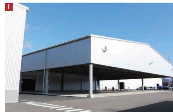
上空から見える**画像I**は生産したPBの保管倉庫および製品積み込み場。大きく屋根が張り出しており、また大型トラックやトレーラーが数台駐機することができる広さがあるため、天候を気にせず、効率よく製品を出荷することができます。
