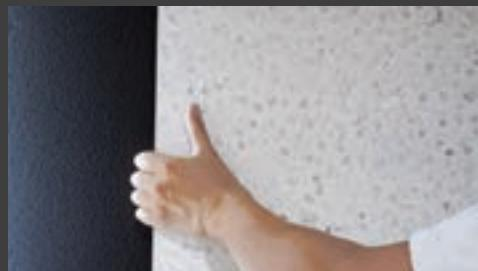
施工は一般的な化粧板と同じく、両面テープと接着剤で行えます。超硬チップソーを取り付けた丸ノコでカットもでき、専用の見切材で小口も綺麗に納まります。専門の職人による手すき和紙の施工を簡単にすることで、国内外における日本の伝統美の発信に貢献します。
