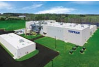
TOPPAN USA ジョージア工場外観
