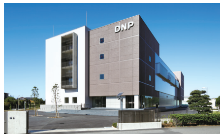
DNP柏データセンター
