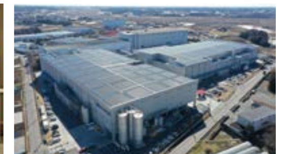
6つの工場、3つの物流施設、1つのリサイクル関連施設が集積した関東八千代エリアでは2022年3月に太陽光発電設備の運転を開始しました。2022年10月には中部エリアでも太陽光発電の運転を開始しています。
