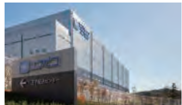
八王子配送センター
